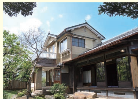
復元工事を終え、公開が始まった市指定文化財の「旧山崎家別邸」。川越の新たな観光スポット。
