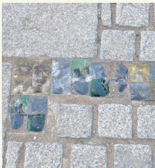
割れたガラス 敷石にはめ込まれたガラス。火災の熱で割れや変形が見られる。
