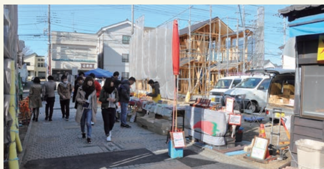
建設現場 火災で焼失した菓子屋横丁の県道沿いで建設中(3/25現在)の菓子店「稲葉本舗」。周辺も再建に動いている。
