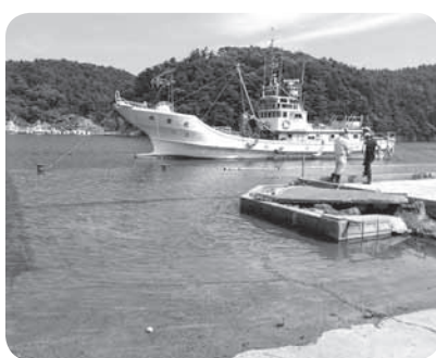
地盤沈下し、浸水した漁港
